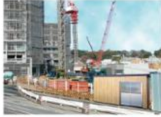
●工事現場での仮設事務所
