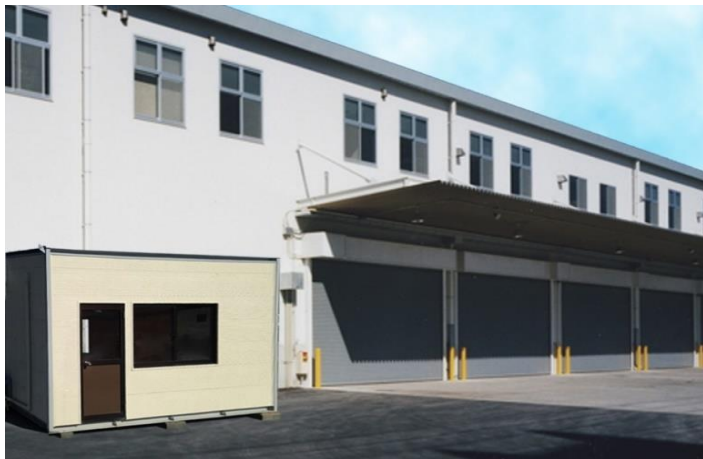
●倉庫敷地内での休憩室・管理室
